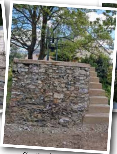
Chantier - le 17 avril 2025
